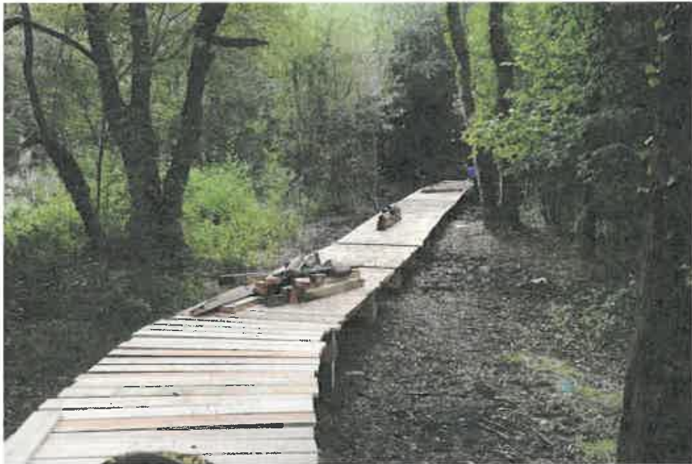
Chantier de platelage - Pleugriffet
